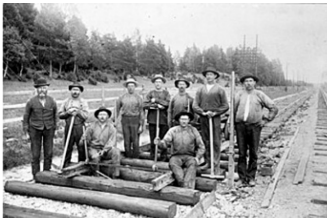
Arbete på Ostkustbanan, dubbelspår mellan Stockholm och Uppsala vid Alsike. Cirka 1900.
